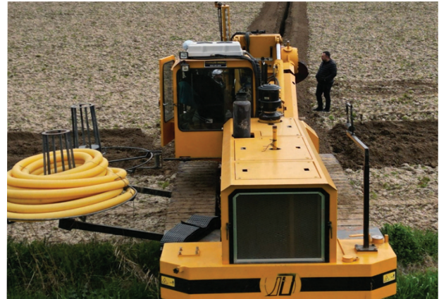
Şekil 5.: Yeraltı Drenaj Sisteminin Kurulum Sürecinden Bir Görünüm: Özel makineler kullanılarak gerçekleştirilen bu çalışmada, sarı renkli drenaj kanalı açma makinesi, toprağın altında delikli borular döşemektedir. Bu sistem, toprak koşullarını iyileştirmek ve tarlada su baskını ile tuzluluk sorunlarını önlemek amacıyla uygulanmaktadır.
