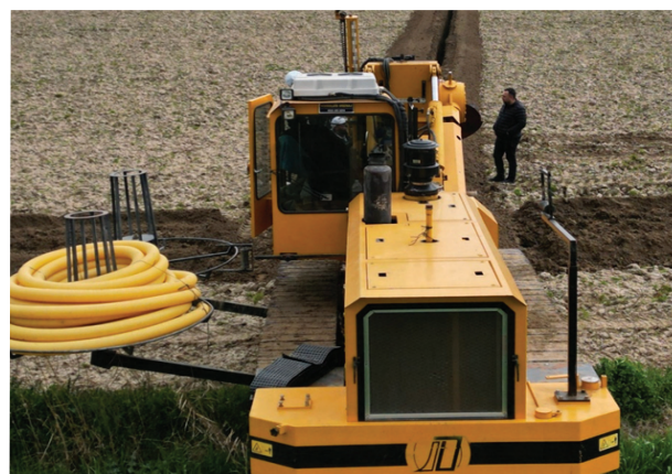
Figura 5: Vista del proceso de instalación de un sistema de drenaje subterráneo con maquinaria especializada. La zanjadora de drenaje amarilla instala tuberías perforadas bajo tierra para mejorar las condiciones del suelo y prevenir problemas de encharcamiento y salinidad en el campo.
