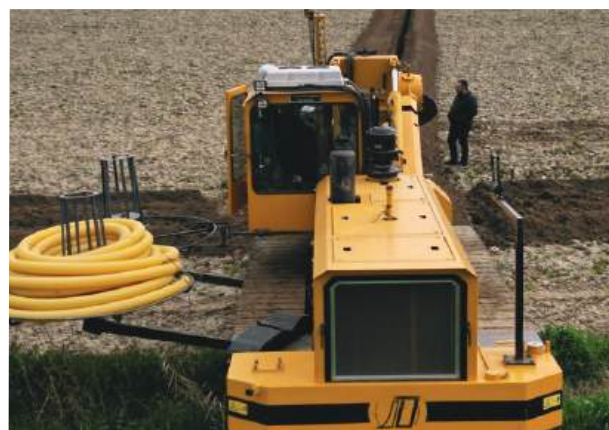
Figura 5: Installazione di un sistema di drenaggio sotterraneo: il trencher giallo posa tubi perforati per migliorare il drenaggio e prevenire ristagno idrico e salinità del suolo.
