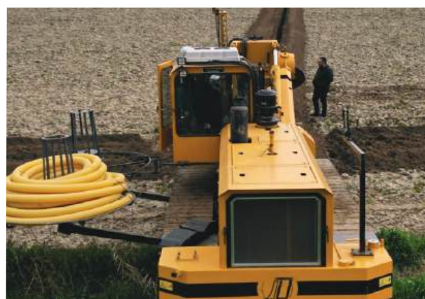
Εικόνα 5: Άποψη της διαδικασίας εγκατάστασης ενός υπόγειου συστήματος αποστράγγισης με τη χρήση εξειδικευμένων μηχανημάτων. Η κίτρινη τάφρος αποστράγγισης τοποθετεί διάτρητους σωλήνες υπόγεια για να βελτιώσει τις συνθήκες του εδάφους και να αποτρέψει προβλήματα υπερχειλίσσης και αλατότητας στο χωράφι.
