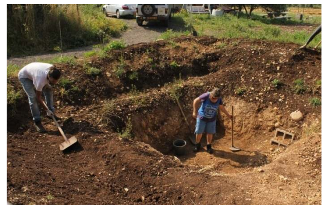
Figura 17: L'equip prepara el terreny per a l'establiment d'un estany ecològic.
